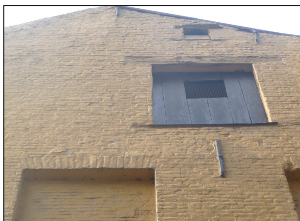
Detail zijgevel met overblijfsel hijsinstallatie
