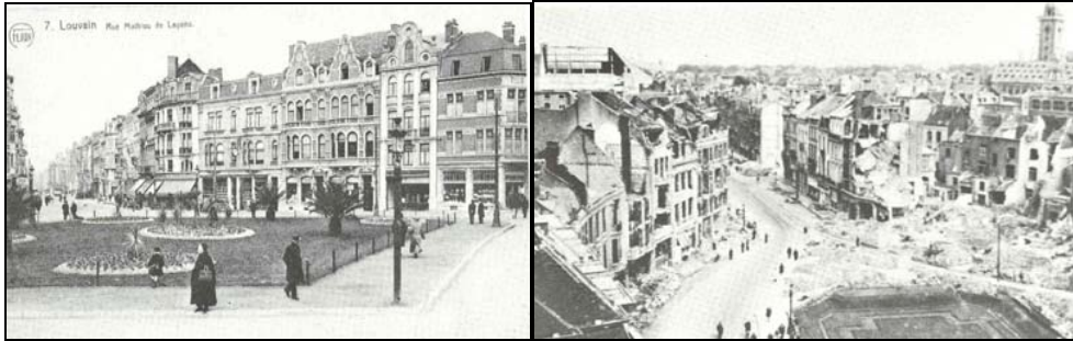
Fochplein met de wederopbouwarchitectuur na WO I. Plein opnieuw verwoest in WO II
