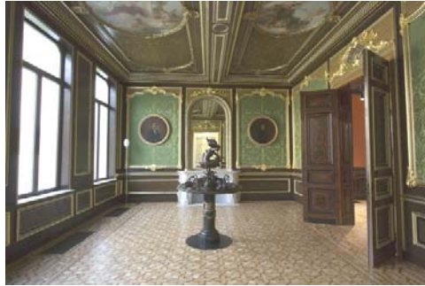
Restauratie van de Salons Vander Kelen-Mertens Foto en realisatie Stad Leuven – Technische dienst
