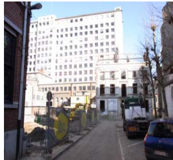
Zicht op vrijgemaakte hoek (links) met de opgravingen zich situeren
